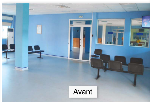
Revêtement des sols et installation de box
